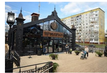
ФАСАД (70% ОСТЕКЛЕНИЕ, 30% МЕТАЛ И СТЕКЛОПЛАСТИК)
