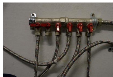
СИСТЕМА РАСПРЕДЕЛЕНИЯ ПОДАЧИ ВОДЫ
